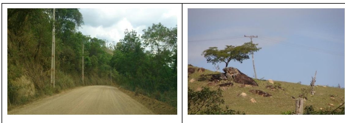
Fotos 1 e 2 - Rede de distribuição de energia na área rural, com utilização de postes de concreto (a esquerda) e de madeira (a direita).
